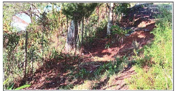
Foto 6: reparación de malla y tuvos galvanizadas
