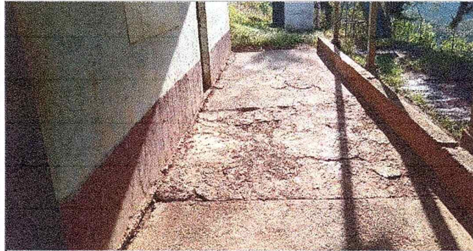
Foto 3: sustitucion de piso de concreto patio
