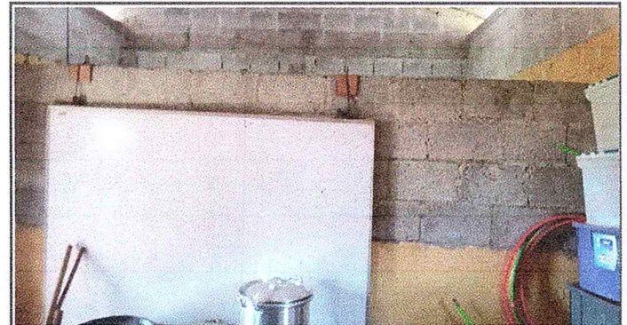
Foto 4: reoparacion de repello pared interior
