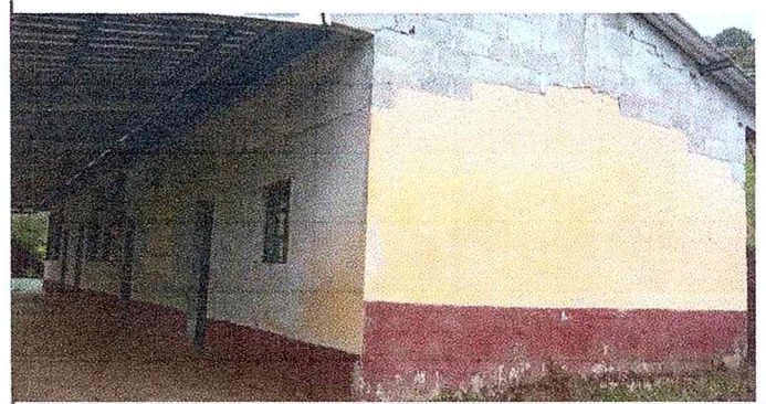
Foto 2: reparación de repello pared exterior
